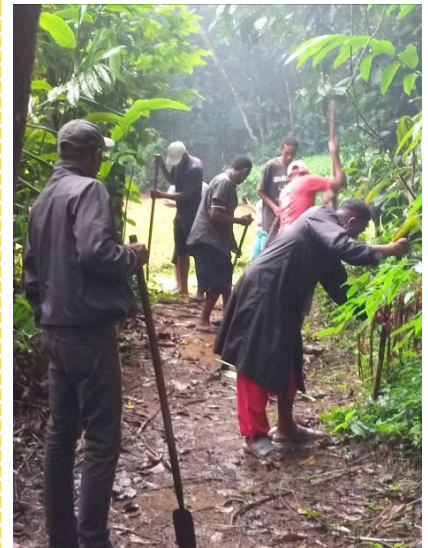
Foto 11: Instandsetzung des Rundgangs Ambatomanara
