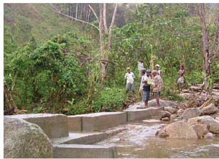
Wasserkanal mit einem Umfang von 40 Hektaren in Biraoka Tanambao. Gemeinde Rurale Mahalevona.
