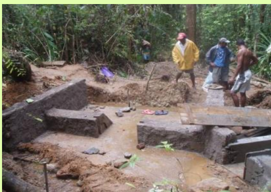
Barrage de 4 mètres à Ambodiforaha (fin juillet)
