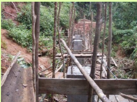
Pont bache de 27 mètres de Manambia (fin juillet)
