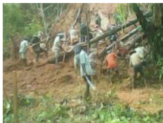
Dégagement d'un canal d'irrigation de rizière suite à un éboulement
