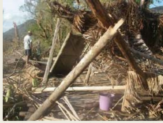
Vollständig zerstörte Gemeindeschule von Ambodiforaha
