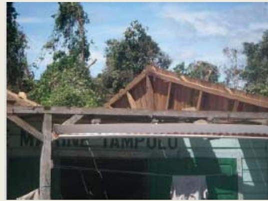
Beschädigte Unterbasis der Seeparzelle
