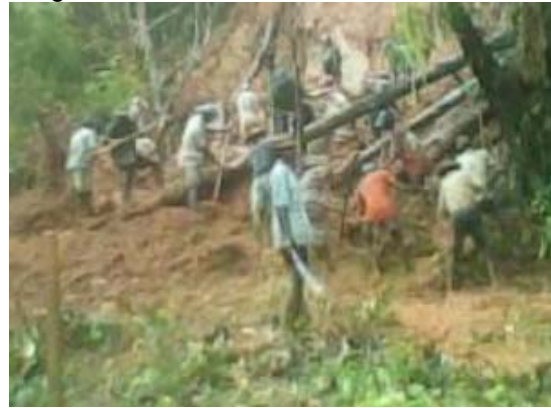
Freilegung eines Reisfeldbewässerungskanal nach einem Erdbeben
